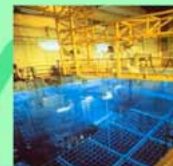
Kiégett fűtőelemek pihentetése (~ 5év)
